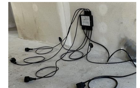
Voorbeeld keukenverdeler met aangesloten kabels
