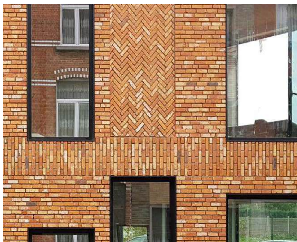
Het metselwerk kent een zorgvuldige detaillering en heeft een industriële uitstraling.
