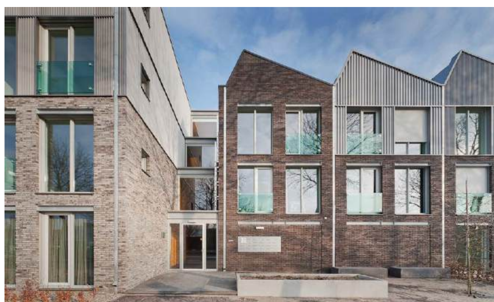
Staande raamopeningen met terugliggende kozijnen
